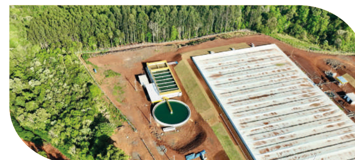
ETE de São Jorge D'Oeste (PR).
